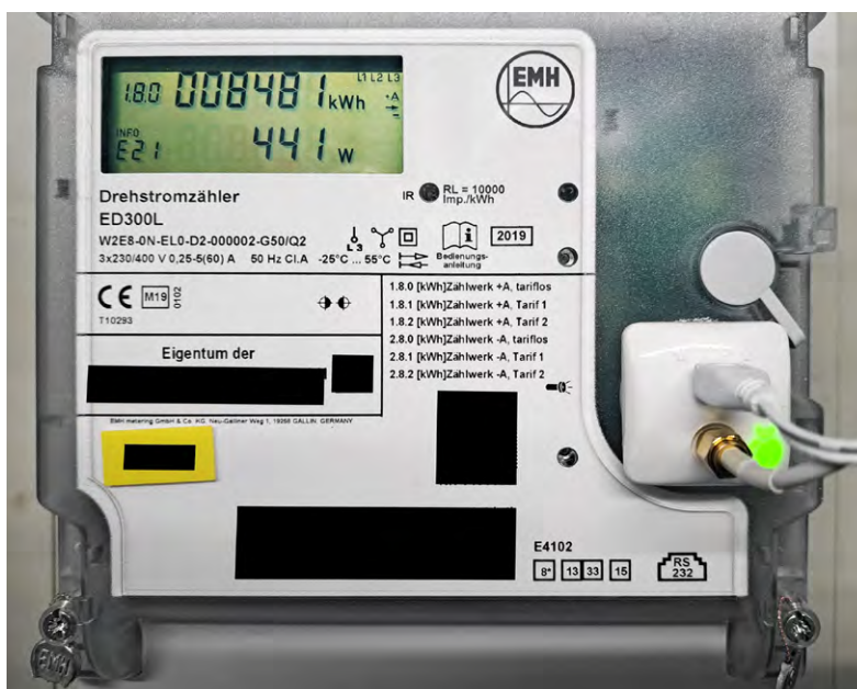
Bild 3: Digitaler Zähler mit auf der optischen Schnittstelle montiertem poweropti. Das Modul hält durch einen Magnetring und zusätzlichen Klebering.
