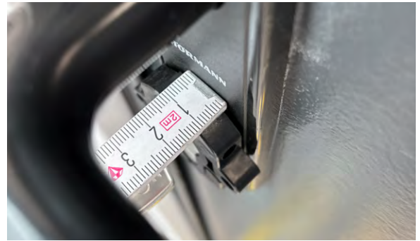
Bild 2: Ein gewisser Überstand ist zwingend nötig.
